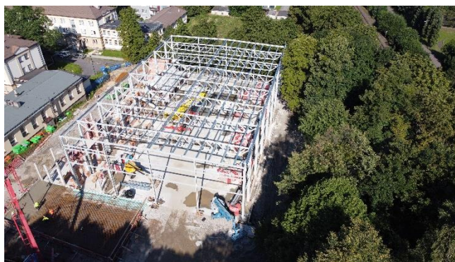
stavba sportovní haly
